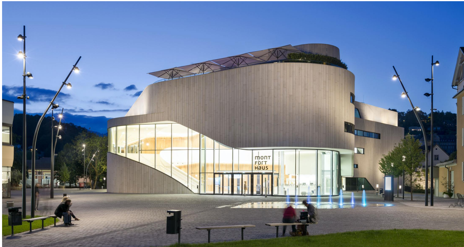
LDE Belzner Holmes_Montforthaus Feldkirch Aussenbeleuchtung_Fotograf Kolm
