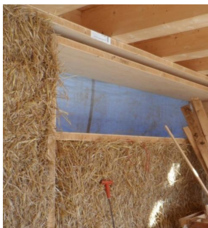
Obrázek 29 Ilustrační foto z výstavby domu ze slámy (Zdroj: http://slamacek.cz/ )
