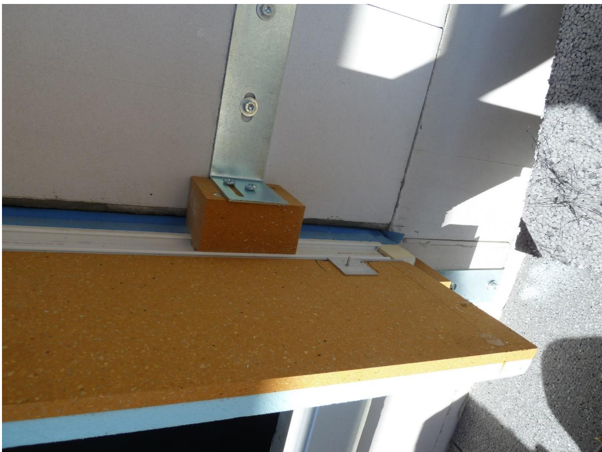
Obrázek 11: První krok předsazené montáže. (zdroj: PORSENNÁ o.p.s.)
