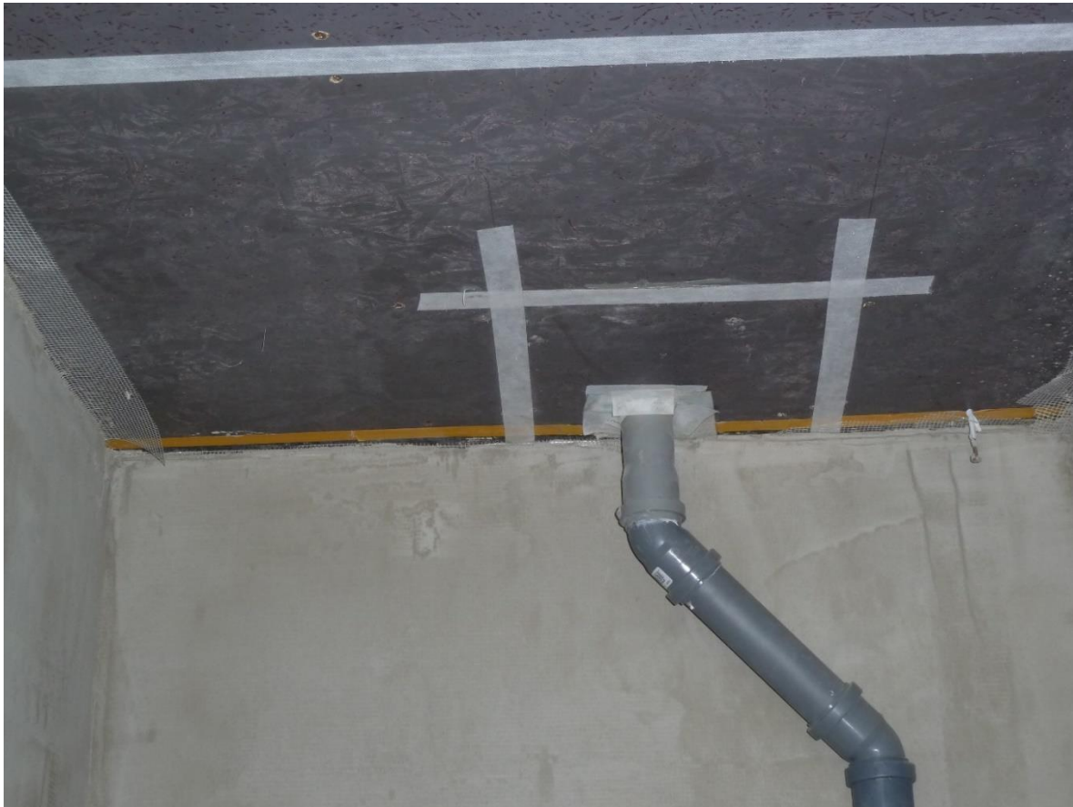
Obrázek 11: První krok předsazené montáže. (zdroj: PORSENNÁ o.p.s.)
