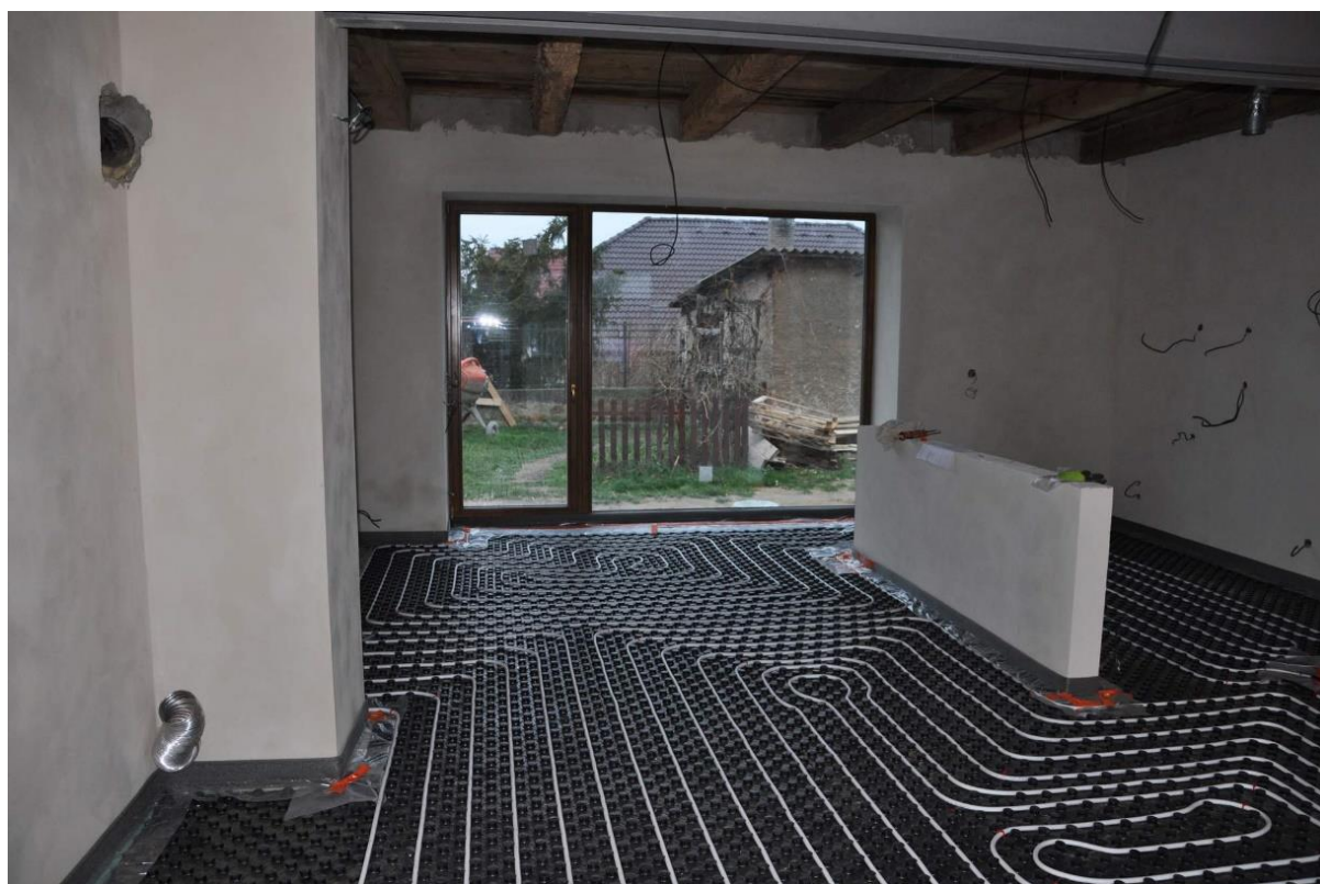
Obrázek 25 Otopná soustava s tepelným čerpadlem často využívá podlahové vytápění. Při návrhu a realizaci podlahového vytápění je podstatné dodržené hlavních zásad – dostatečné hustoty a rovnoměrnosti topných rozvodů. (zdroj: PORSENNA o.p.s.)
