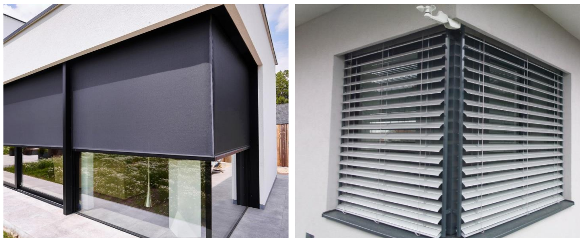
Obrázek 32 Ukázka vnějších aktivních stínících prvků (zdroj: www.lomax.cz )
