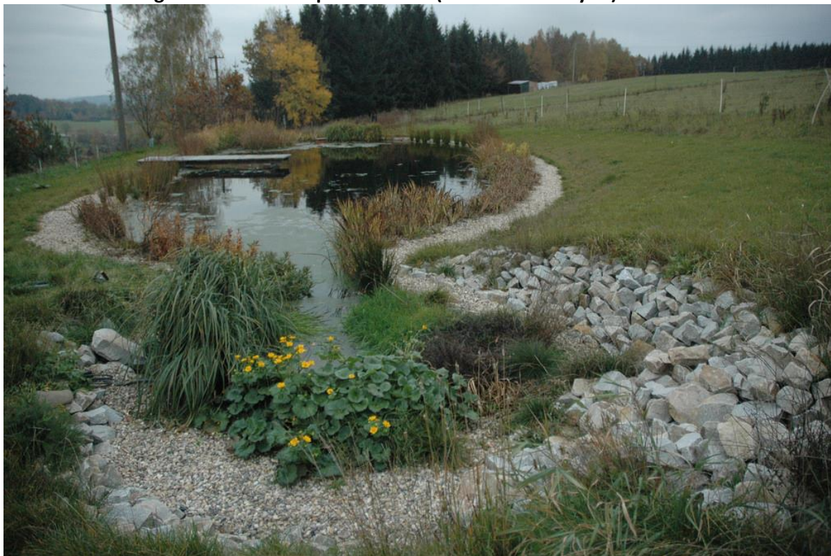
Obrázek 28 Vegetační čistírna odpadních vod. (Foto: Kořenovky.cz)
