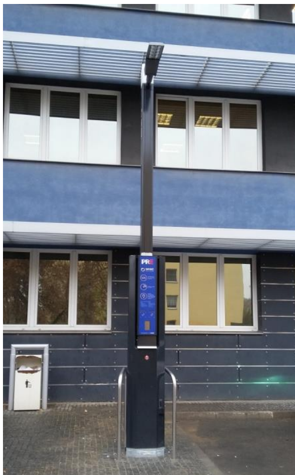
Obrázek 17 Víceúčelové sloupy veřejného osvětlení jsou již v běžné nabídce výrobců, ale jejich prosazení závisí mimo jiné na koncepci integrovaného přístupu v daném městě a v případě integrace dobíjecích stanic také na vývoji tarifního systému (foto: www.allforpower.cz )
