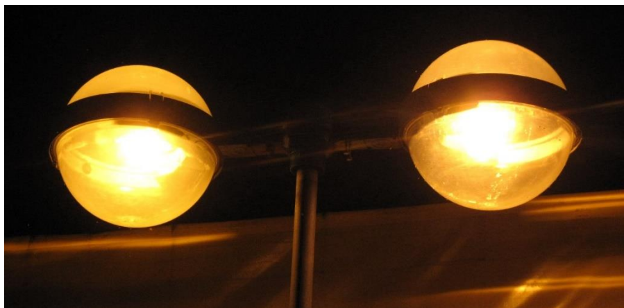
Obrázek 5 Rušivé světlo z necloněného svítidla s vyzařováním světelného toku do horní poloviny (foto Theodor Terrich)
