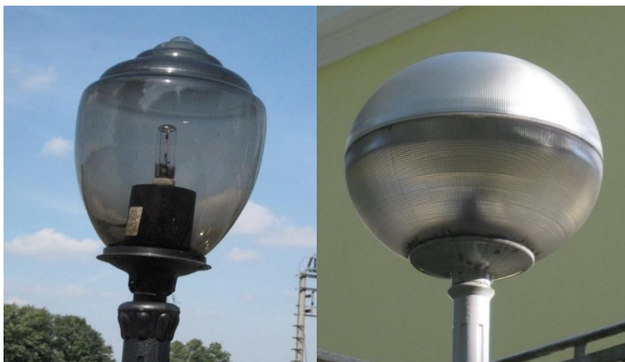
Obrázek 7 Příklad novodobých svítidel. Vlevo zcela nevyhovující svítidlo z hlediska rozložení vyzařovaného světelného toku. Vpravo svítidlo se cloněnou horní polovinou a prismatickým difuzorem (foto: Theodor Terrich)
