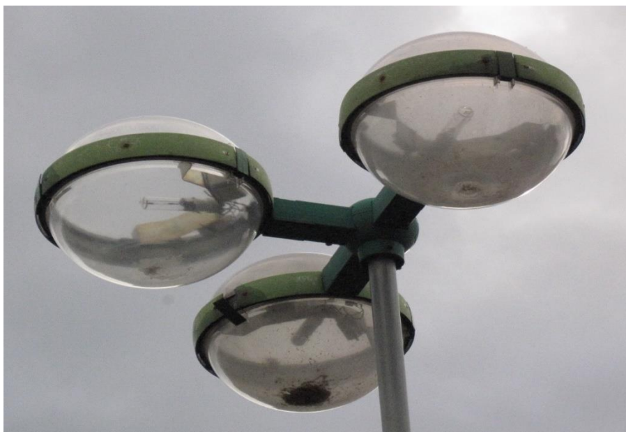
Obrázek 6 Typický příklad necloněného svítidla s prakticky žádným optickým systémem. Světelný tok je vyzařován všemi směry včetně horní poloviny (foto: Theodor Terrich)
