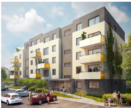
První certifikovaný pasivní bytový dům v ČR
