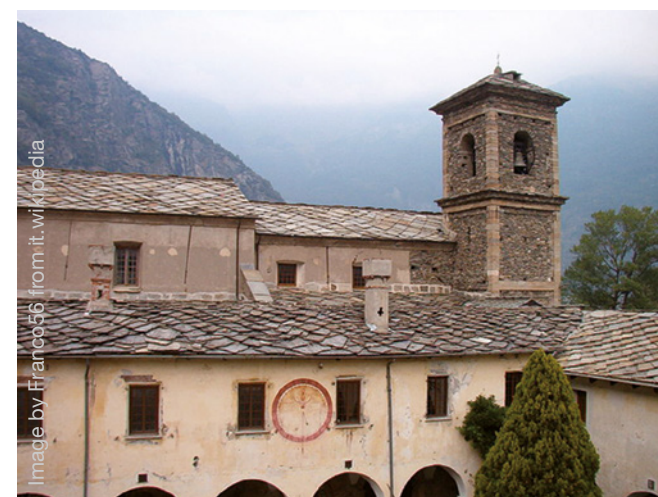
Opatství Noalesa z 12. století, kde má být zřízen systém vytápění na biomasu, který nahradí současnou neefektivní instalaci nafty.
