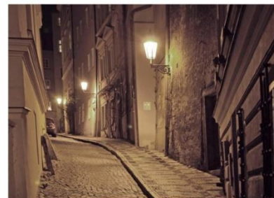
407 Příklad umístění svítidel veřejného osvětlení na fasády budov ve stísněných prostorech [ Praha 1, Jánkův vršek ]
